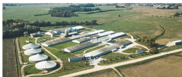
Aerofoto no 3. Fermas – sīvēnmāšu fermas Bauskā
